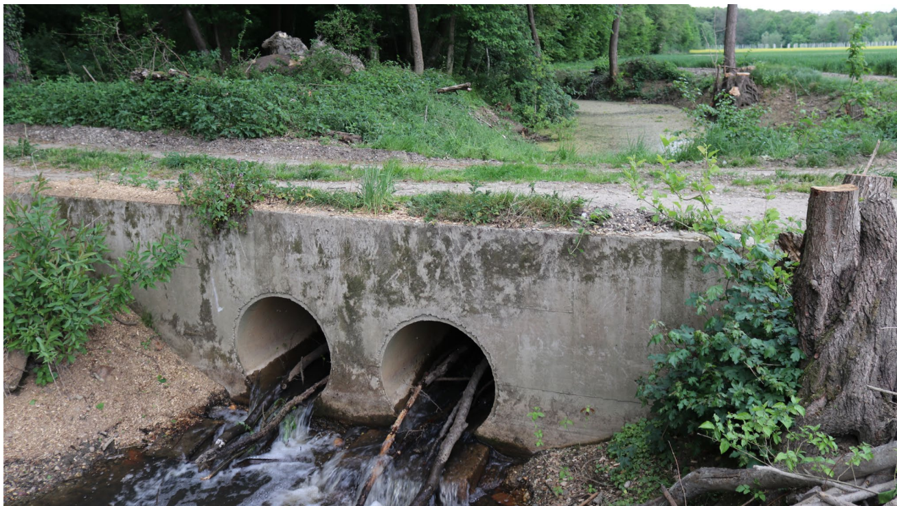
Slika 143. Zamašen cevni prepust.
