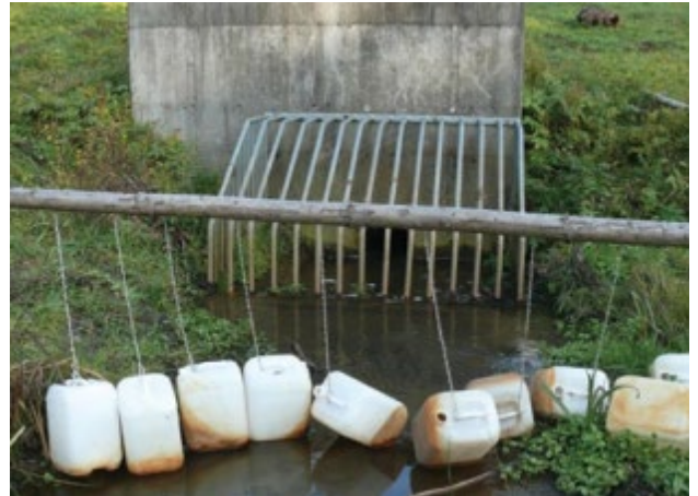
Slika 150. Viseče plastične posode bobru onemogočajo gradnjo in stabilizacijo jezov.
