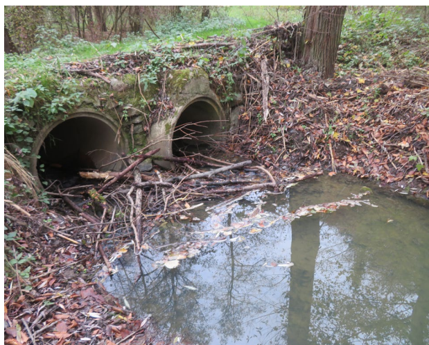
Sliki 98 in 99. Zamašitev cevnih prepustov je za bobra hitrejša kot gradnja celega jezua.
