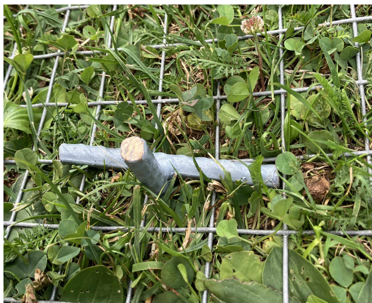
Slika 179. Pritrditev mreže z železnimi palicami.
