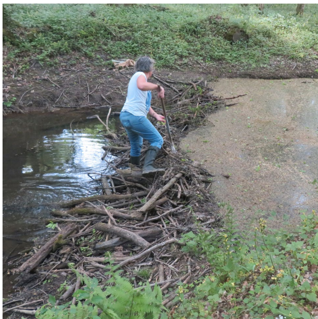
Slika 112. Vrhnji del jezu lahko odstranimo ročno, pomagamo si z orodji, kot so kramp ali vile.
