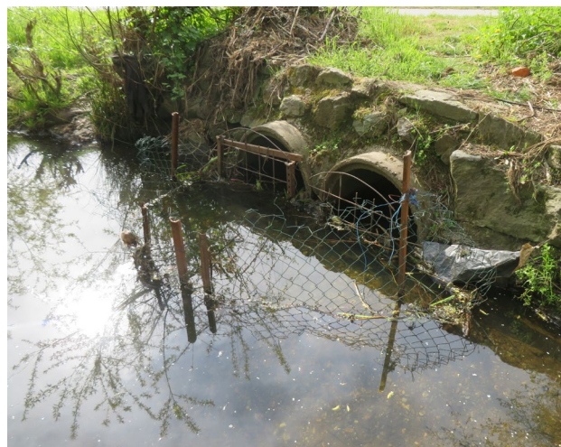
Sliki 145 in 146. Preprosta zaščita cevne prepuste z mrežo in kovinskimi količki.
