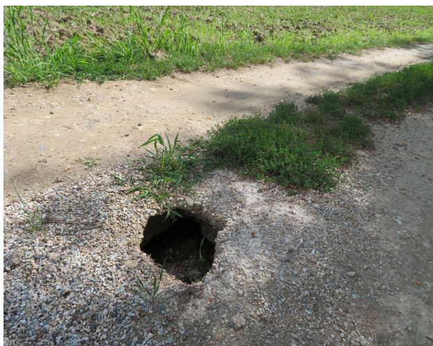
Sliki 165 in 166. Udora rova na lokalni cesti.
