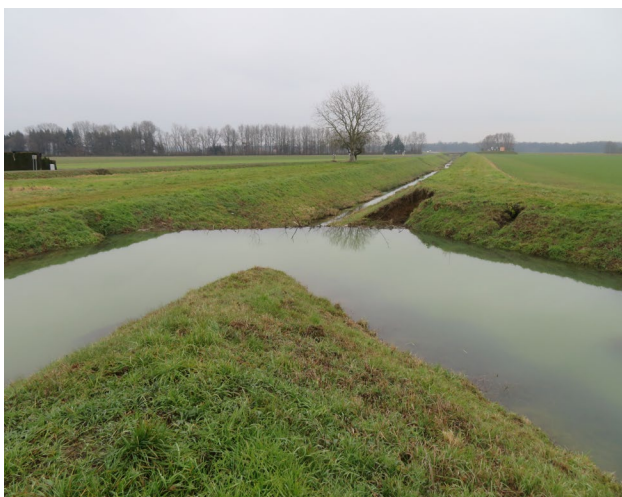
Sliki 171 in 172. Zaradi višjega vodostaja za bobrovim jezum in stalne omočenosti brežine se je udril brlog ob jezu.
