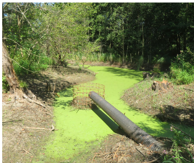
Slika 154. Stanje na starem rokavu reke Mure, kjer je v času suše zaradi odstranitve jezu vodostaj upadel za več kot 70 cm, v strugi pa je ostalo samo približno 5 cm vode.
