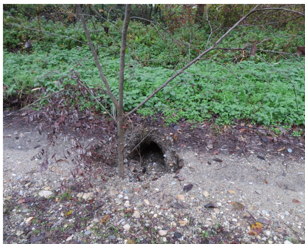
Sliki 165 in 166. Udora rova na lokalni cesti.
