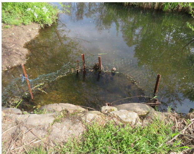
Sliki 145 in 146. Preprosta zaščita cevne prepuste z mrežo in kovinskimi količki.
