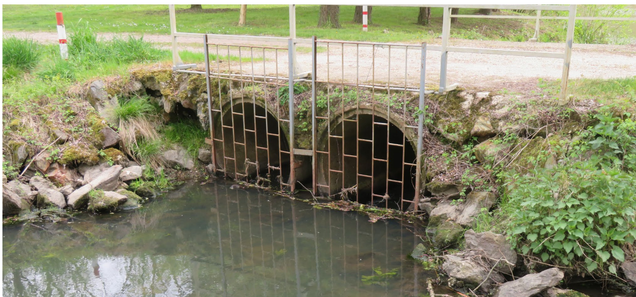
Slika 148. Z rešetkami zaščiten cevni prepust.
