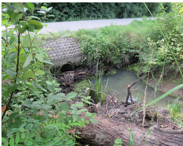
Sliki 98 in 99. Zamašitev cevnih prepustov je za bobra hitrejša kot gradnja celega jezua.
