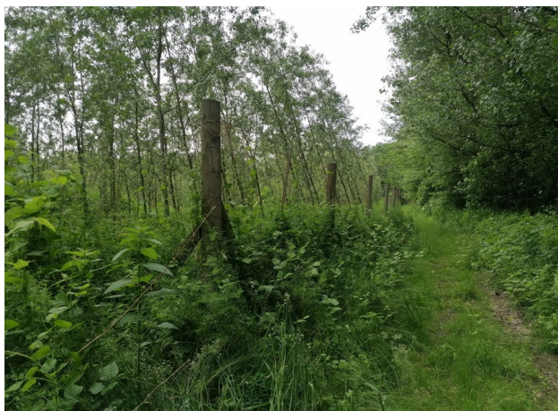
Slika 86. Izključitvena ograja z lesenimi podpornimi stebri.
