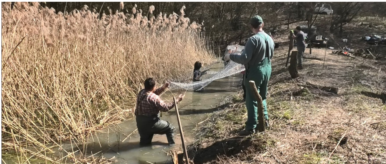
Slika 177. Polaganje mreže za zaščito brežin na Madžarskem.
